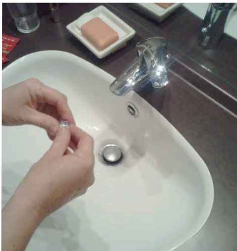
Le nettoyage des aérateurs
