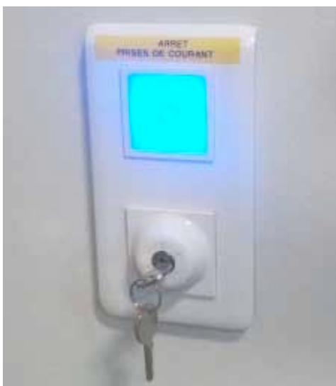
Un interrupteur coupe veille de la Cité
