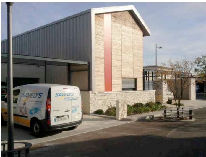
Une camionnette de technicien de maintenance
