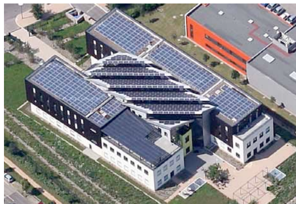
Les panneaux solaires sur le toit de la Cité
