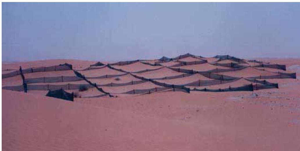
Clayonnage en polystyrène extrudé
